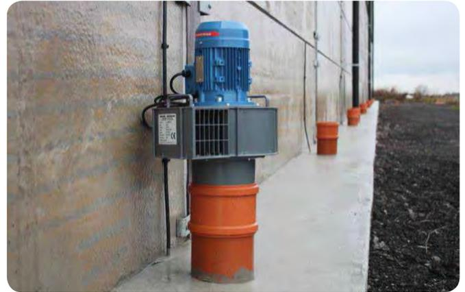
Блок вентилятора з електродвигуном
